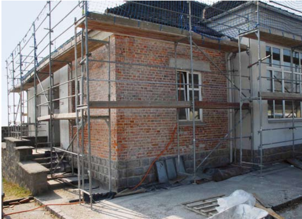
Fassadenarbeiten am ehemaligen Reviergebäude, März 2011. Im Jahr 1945 waren die Wände des Gebäudes unverputzt; mittels Sichtfenster soll ein Eindruck dieses Zustands verschafft werden (© Bundesministerium für Inneres/Stephan Matyus).
